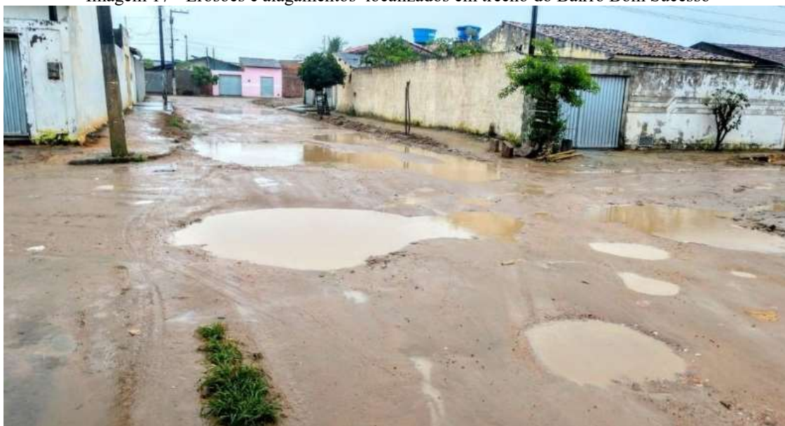
Imagem 17 - Erosões e alagamentos localizados em trecho do Bairro Bom Sucesso
