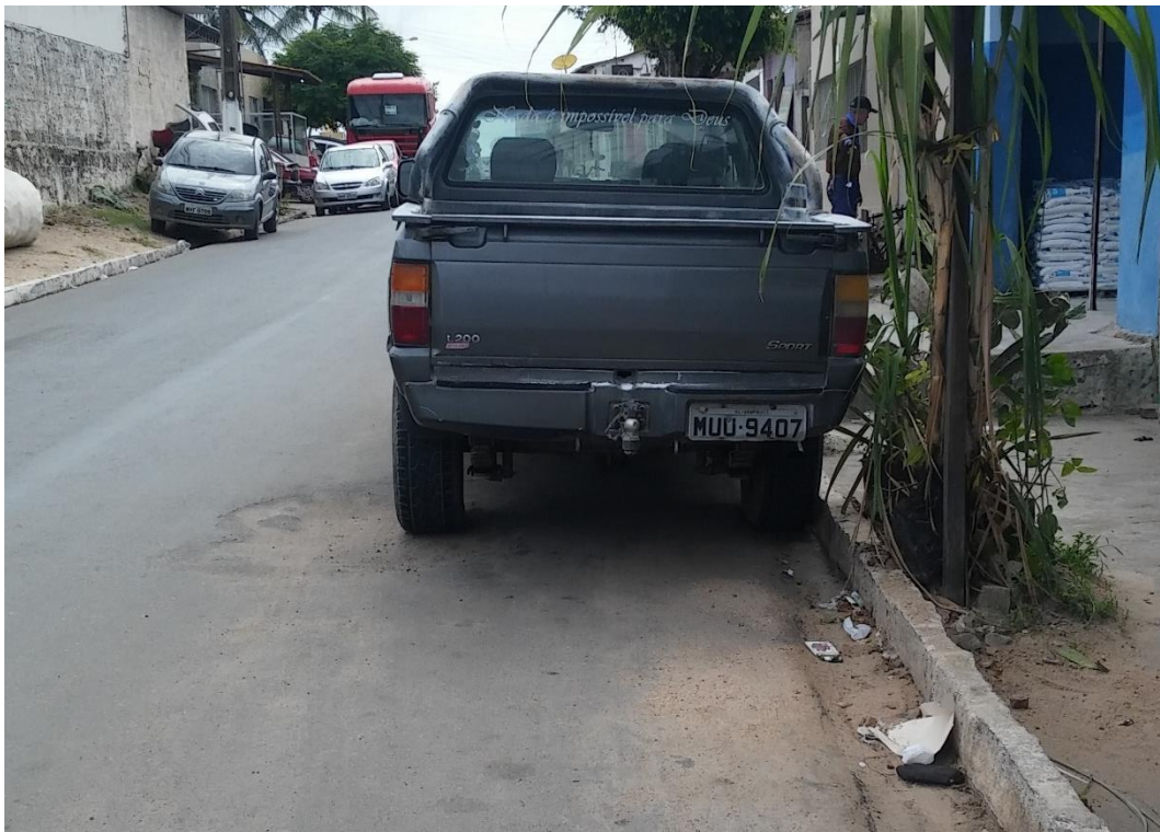
Foto 01 – Buraco por conta de serviços da CASAL (Próx. a borracharia do Branco)
