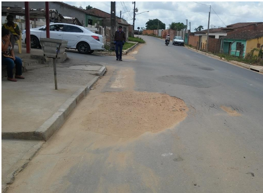
Foto 11 – Buracos por conta de serviços da CASAL (Rua Antônio Feliciano, Próx. ao Bar do Messias)
