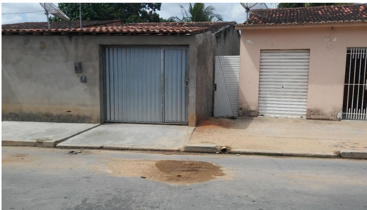
Foto 13 – Buraco por conta de serviços da CASAL (Rua James Magalhães, Próx. a casa 19)
