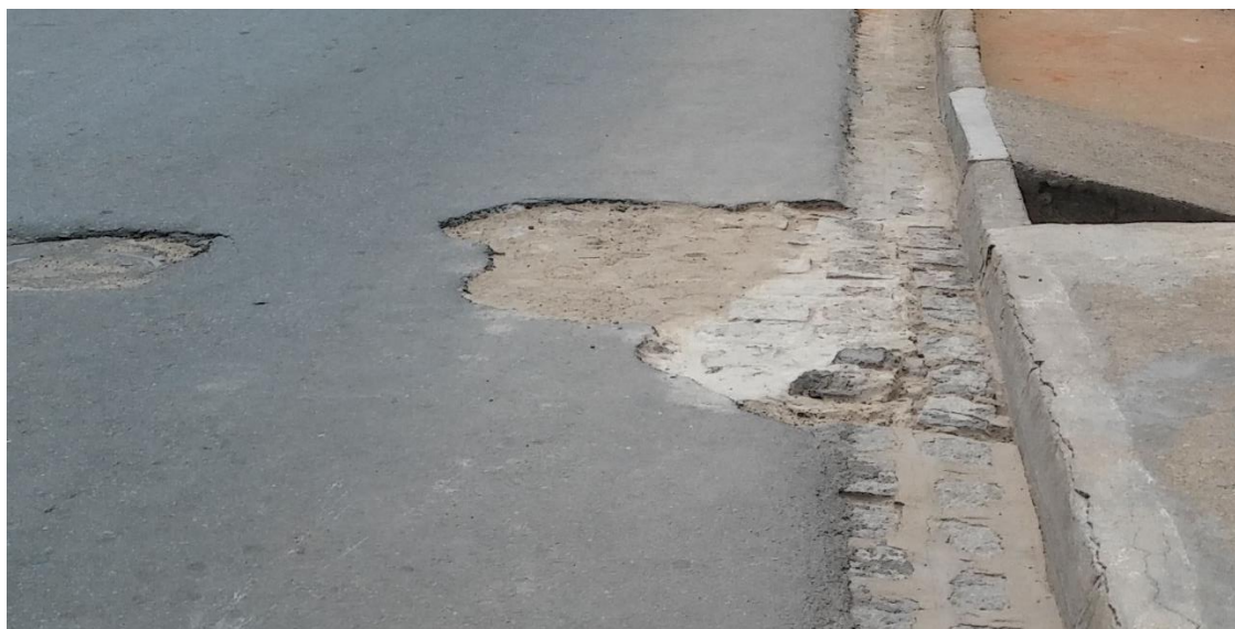
Foto 03 – Buraco por conta de serviços da CASAL (Rua Antônio Feliciano, Próx. a casa 724)
