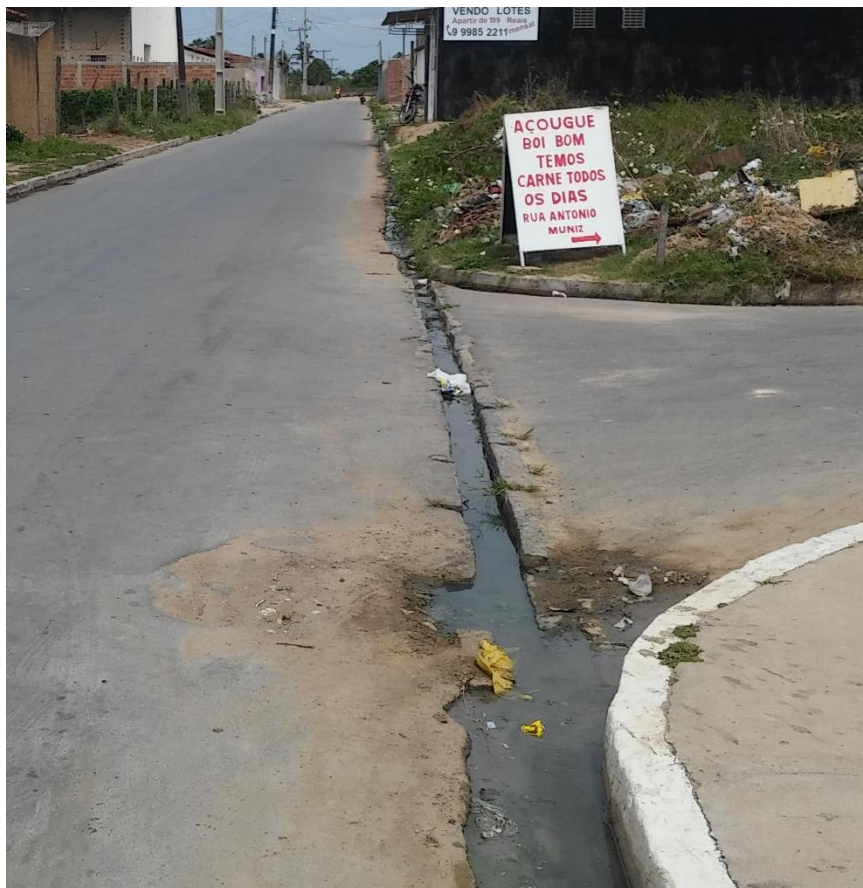
Foto 17 – Buraco por conta de provável má execução de serviços de pavimentação (Próx. a igreja O Brasil para Cristo)
