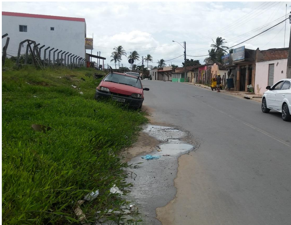
Foto 05 - Buraco provavelmente por não ter escoamento da drenagem (Rua Antônio Feliciano, Próx. a casa 1011)
