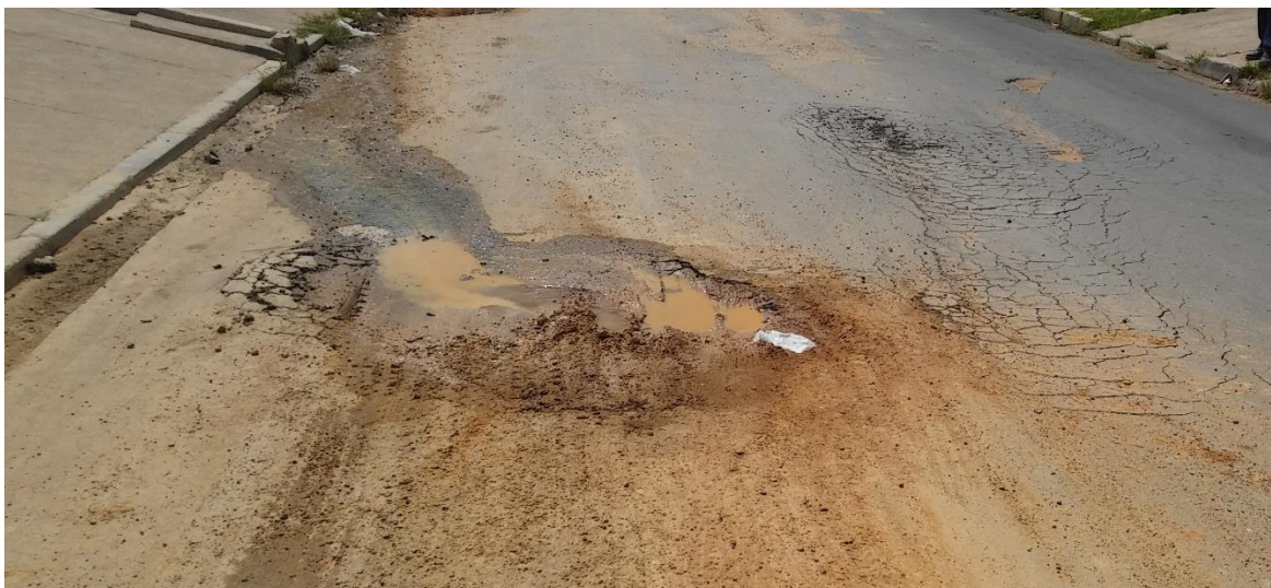
Foto 9 – Buraco por conta de serviços da CASAL (Rua Antônio Feliciano, Próx. ao Mercadinho São Luiz)
