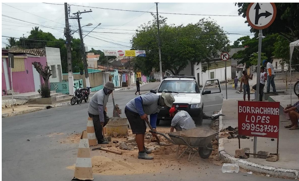
Foto 02 – Buraco próx. à Igreja - Serviço de recomposição de asfalto (terceirizada CASAL)
