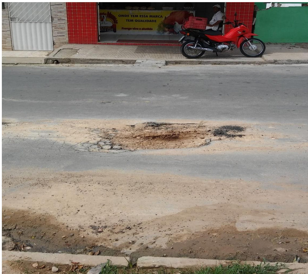
Foto 7 – Buraco por conta de serviços da CASAL (Rua Antônio Feliciano, Próx. a Avícola)
