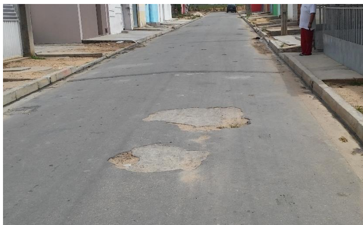
Foto 18 – Buraco por conta de provável má execução de serviços de pavimentação (Rua Antônio Muniz)
