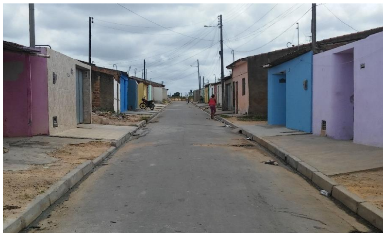
Foto 15 – Buracos por conta de serviços da CASAL (Rua Vandilva Lima)
