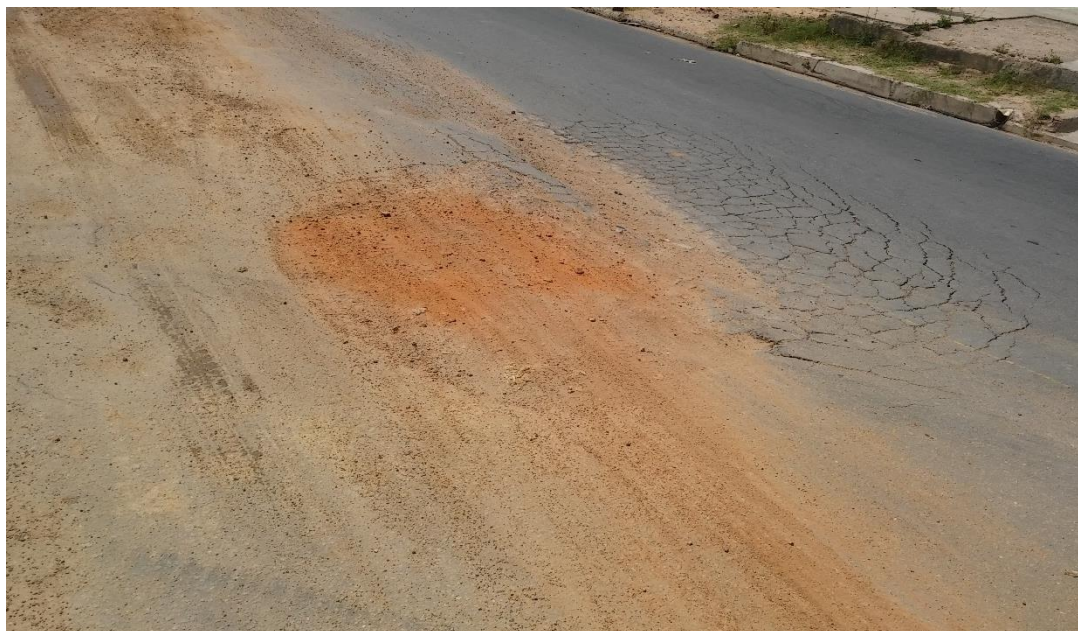
Foto 8 – Trecho recalçou provavelmente devido a falta de compactação (Rua Antônio Feliciano, Próx. ao Mercadinho São Luiz)
