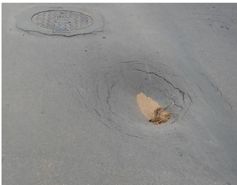
Foto 12 – Buraco por conta de provável má execução de serviços de pavimentação (Rua Antônio Feliciano, Próx. ao bar do Messias)
