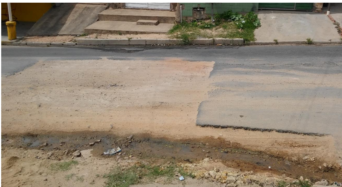
Foto 10 – Buraco por conta de serviços da CASAL (Rua Antônio Feliciano, Próx. a casa 75)
