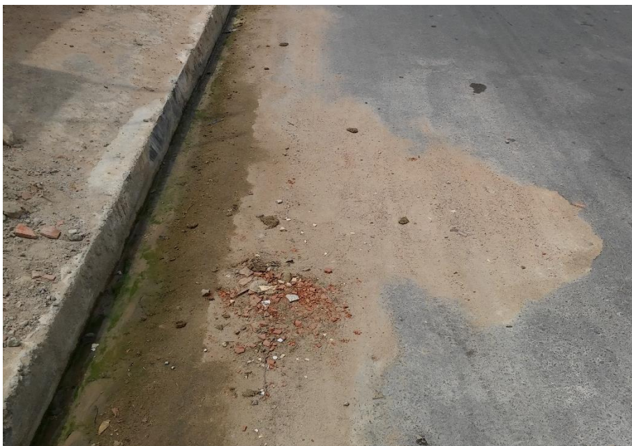
Foto 19 – Buracos por conta de serviços da CASAL (Rua Antônio Muniz, Próx. a casa 58)
