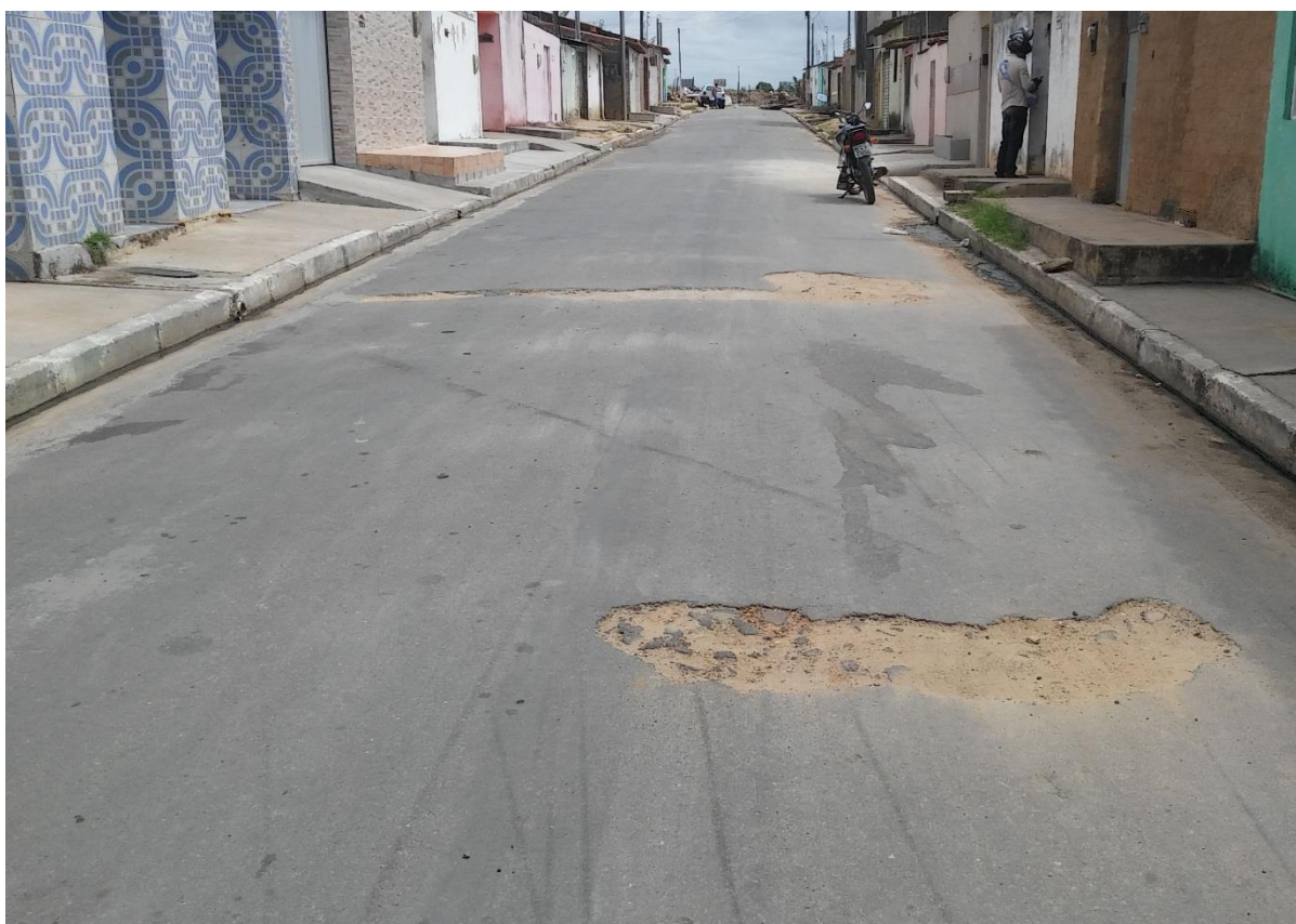
Foto 16 – Buracos por conta de serviços da CASAL (Rua Suzano Barbosa)
