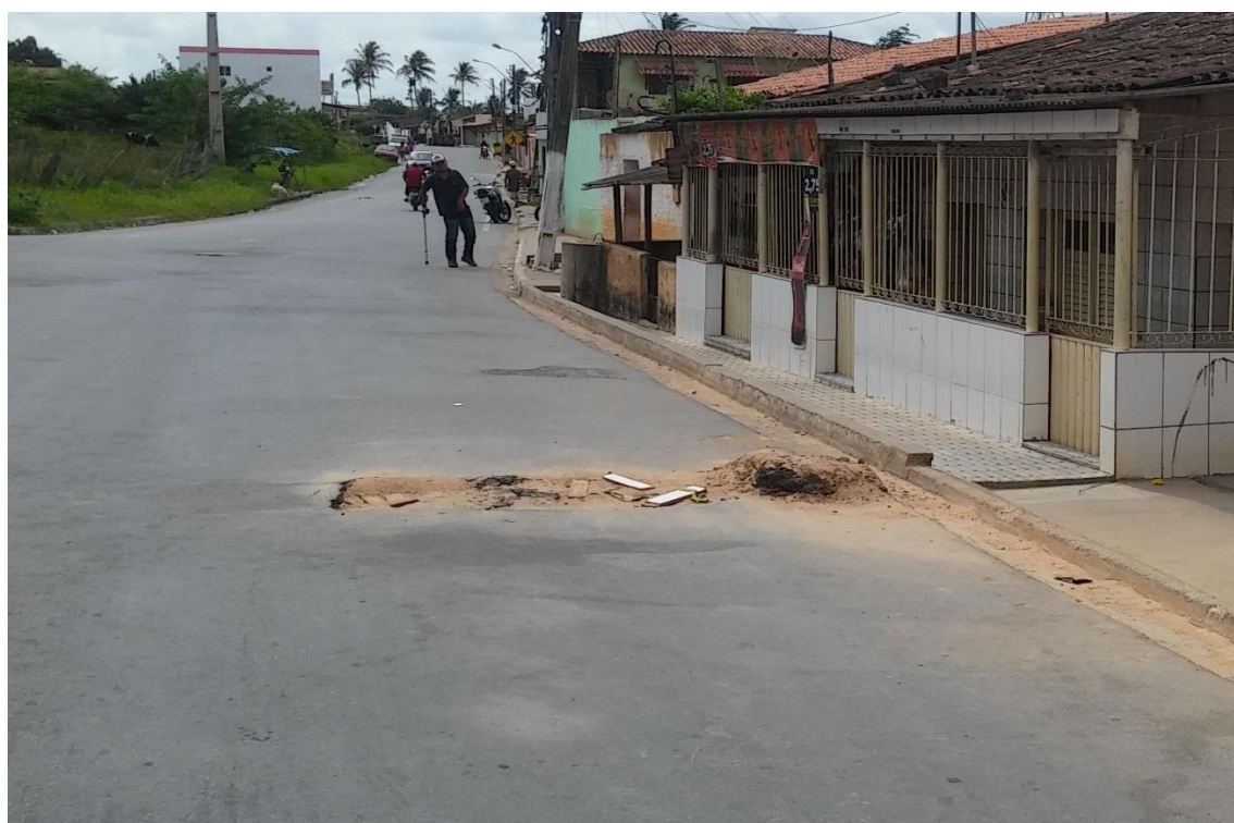
Foto 04 – Buraco por conta de serviços da CASAL (Rua Antônio Feliciano, Próx. a casa 782)
