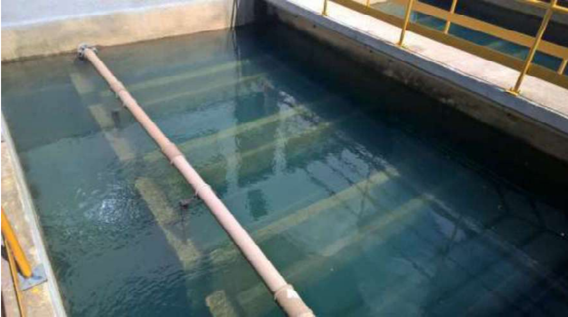
Figura 95. Filtros da ETA 2
