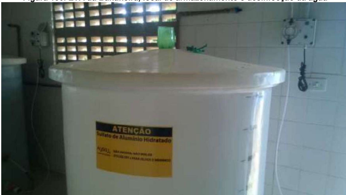
Figura 150. ETA da Bananeira, local de armazenamento e desinfecção da água
