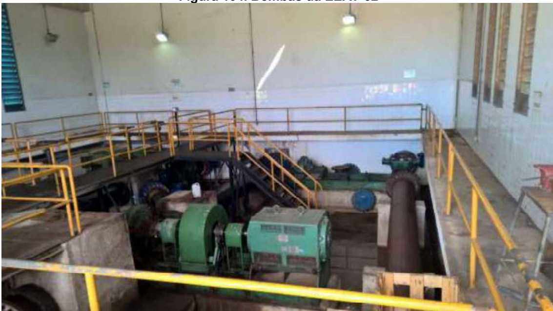
Figura 104. Bombas da EEAT-02
