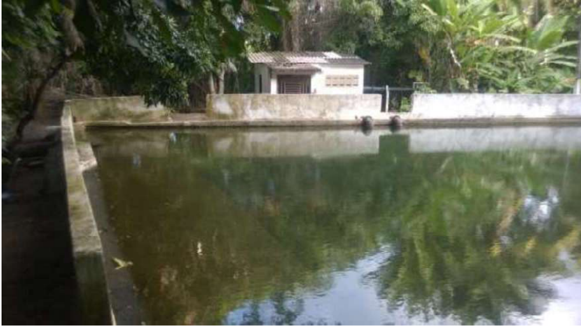
Figura 146. Barramento da nascente com a captação e elevatória ao fundo
