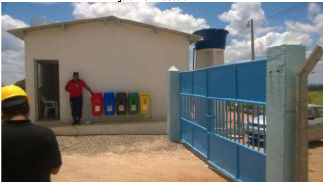
Figura 123. Entrada a EEAB 2
