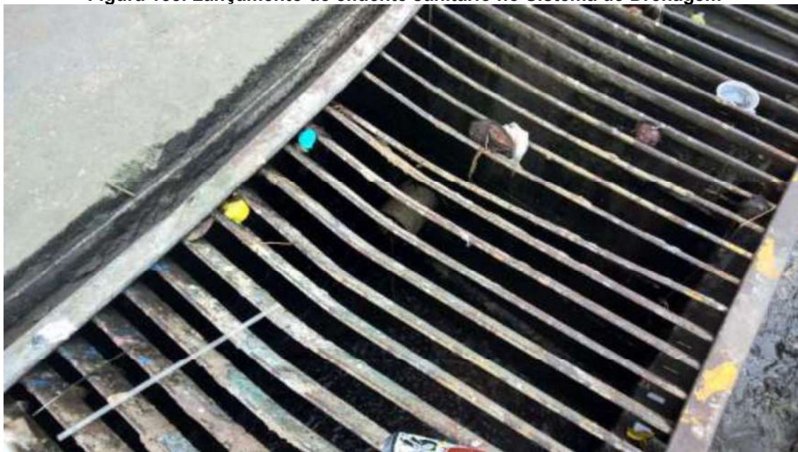
Figura 158. Lançamento de efluente sanitário no Sistema de Drenagem
