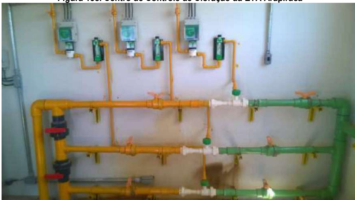
Figura 138. Centro de Controle de Cloração da ETA Arapiraca
