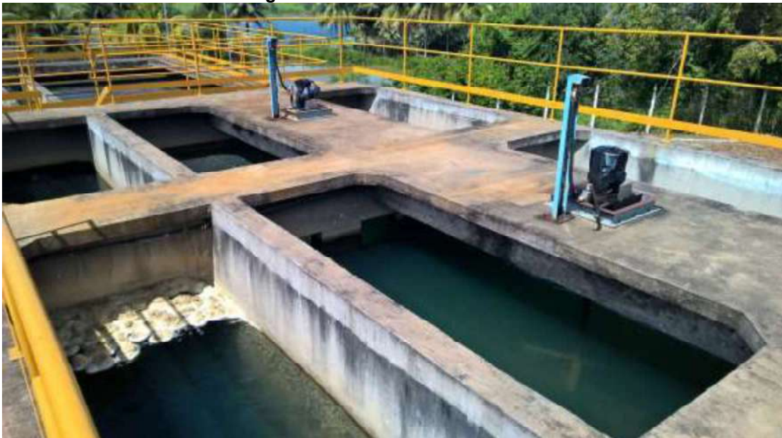
Figura 93. Floculadores da ETA 2
