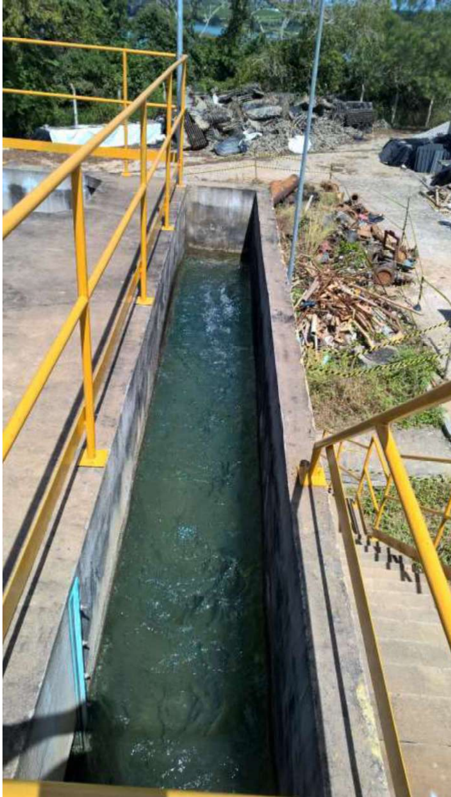
Figura 92. Chegada da água bruta
