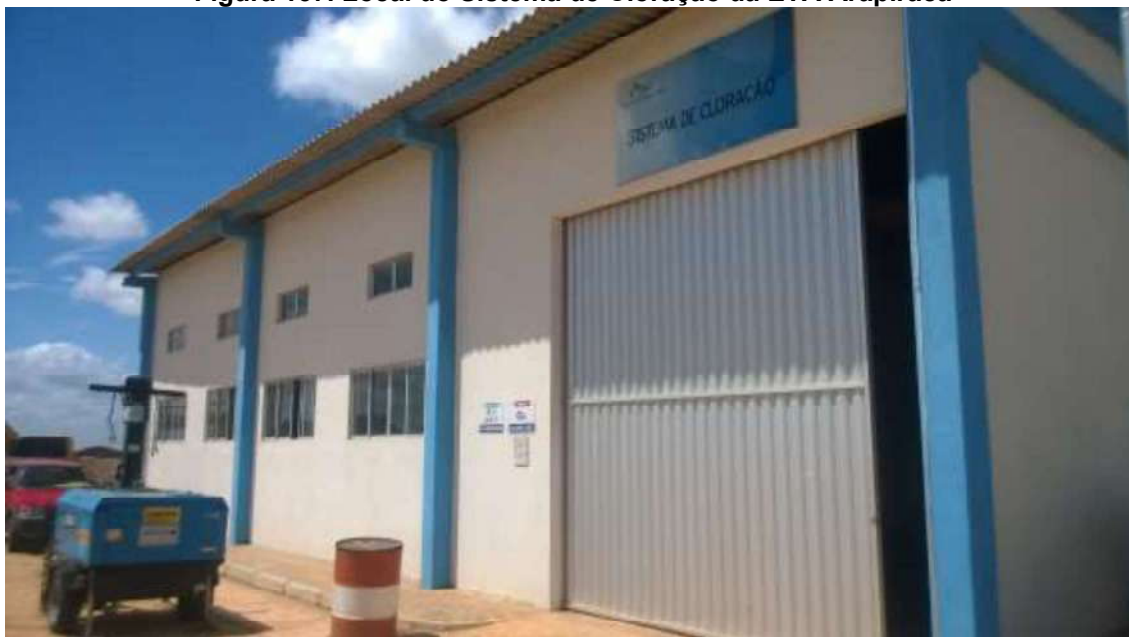
Figura 137. Local do Sistema de Cloração da ETA Arapiraca
