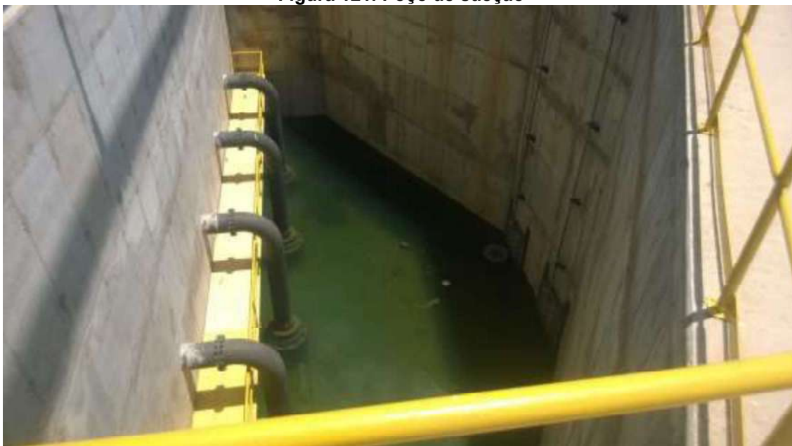
Figura 121. Poço de sucção
