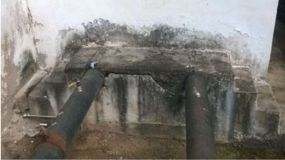
Figura 148. Rachaduras na estrutura da Estação Elevatória
