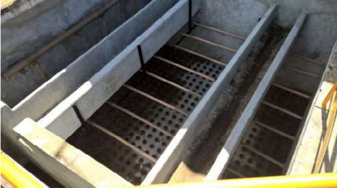
Figura 91. Filtro da ETA 1 em manutenção
