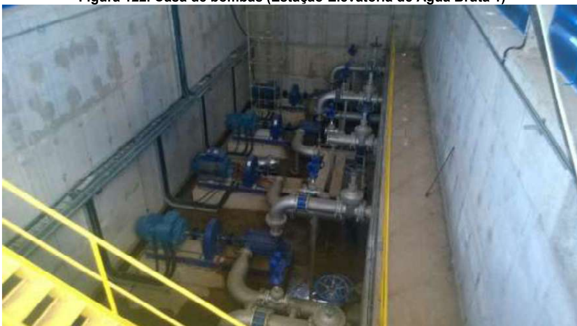
Figura 122. Casa de bombas (Estação Elevatória de Água Bruta 1)
