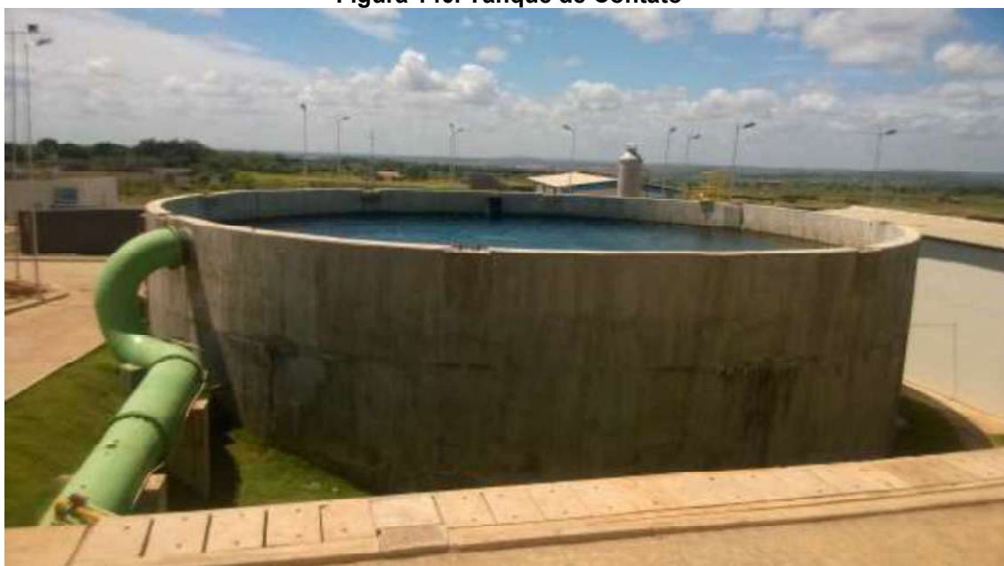
Figura 140. Tanque de Contato
