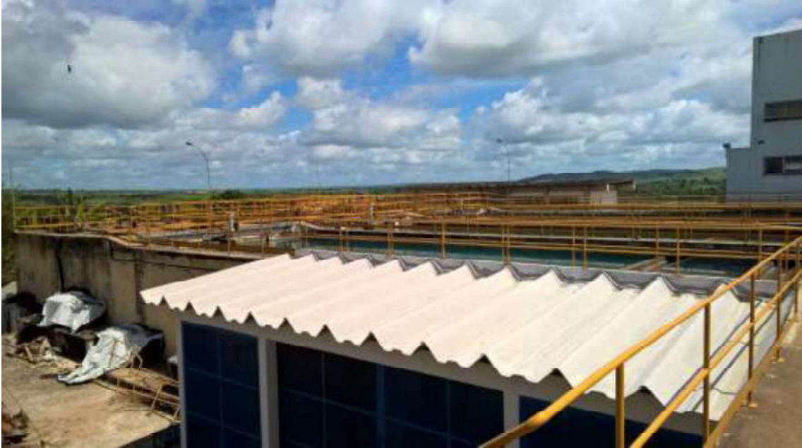
Figura 97. Módulo de Tratamento 01 da ETA do Morro do Gaia
