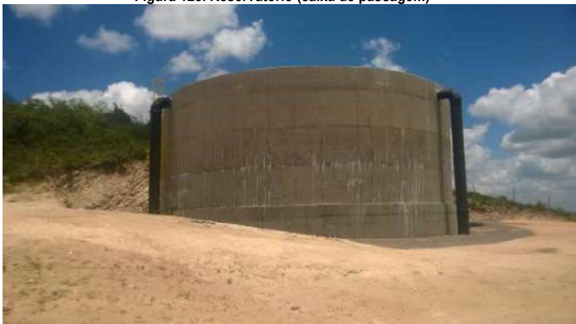
Figura 128. Reservatório (caixa de passagem)
