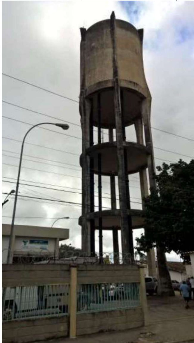
Figura 111. Centro de Reservação e Distribuição de Arapiraca: CRD-01
