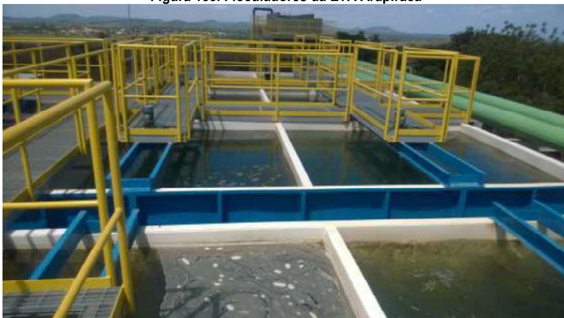
Figura 133. Flocculadores da ETA Arapiraca
