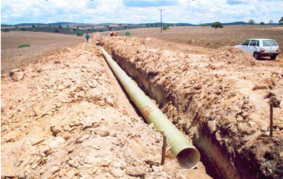
Figura 108. Fotografia de trecho da adutora do agreste em DN450
