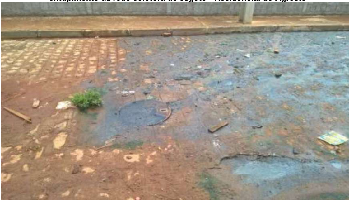
Figura 182. Vazamento do efluente não tratado em via pública decorrente do entupimento da rede coletora de esgoto - Residencial do Agreste
