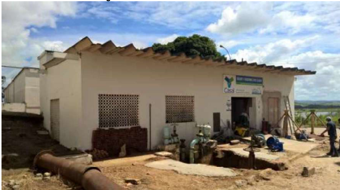
Figura 101. EEAT-01 do Morro do Gaia
