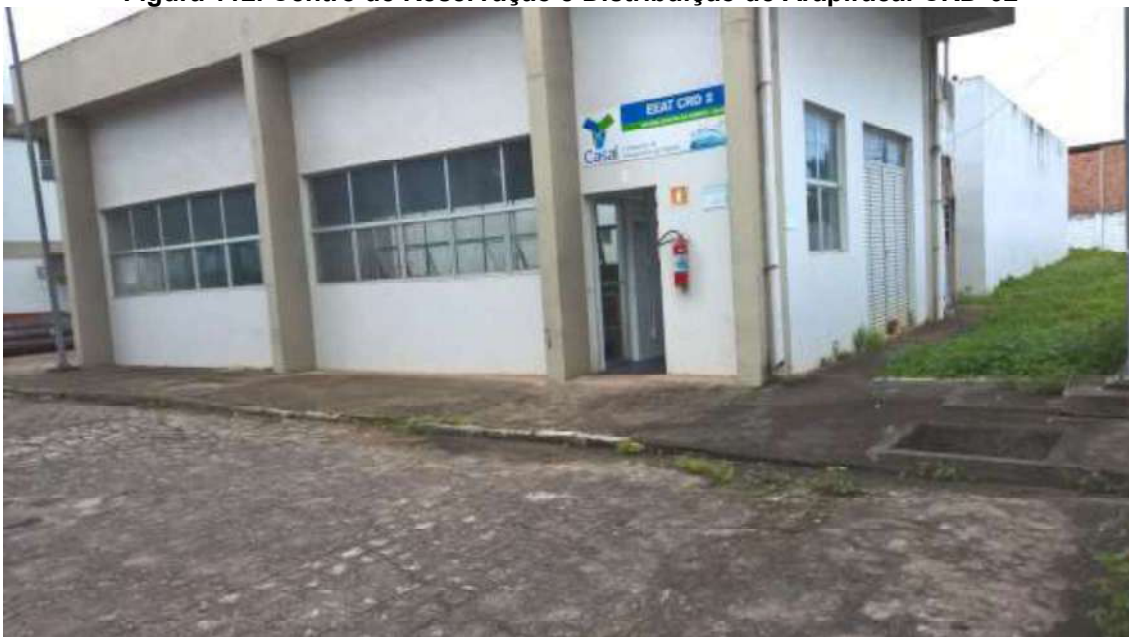
Figura 112. Centro de Reservação e Distribuição de Arapiraca: CRD-02
