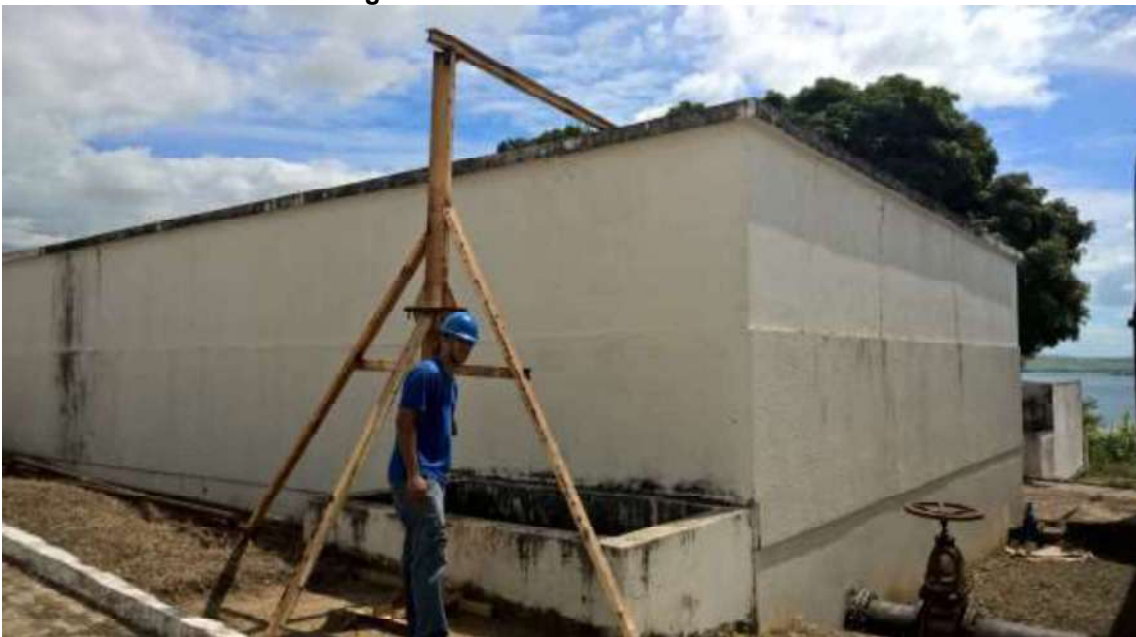
Figura 100. Reservatório de Contato
