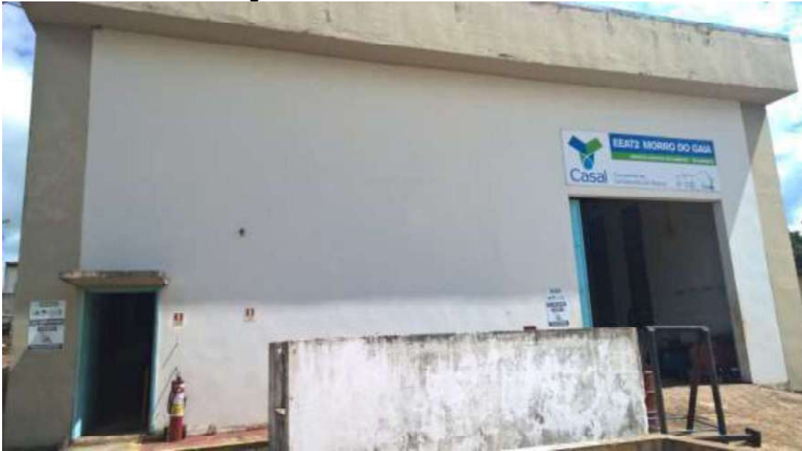
Figura 103. EEAT-02 do Morro do Gaia
