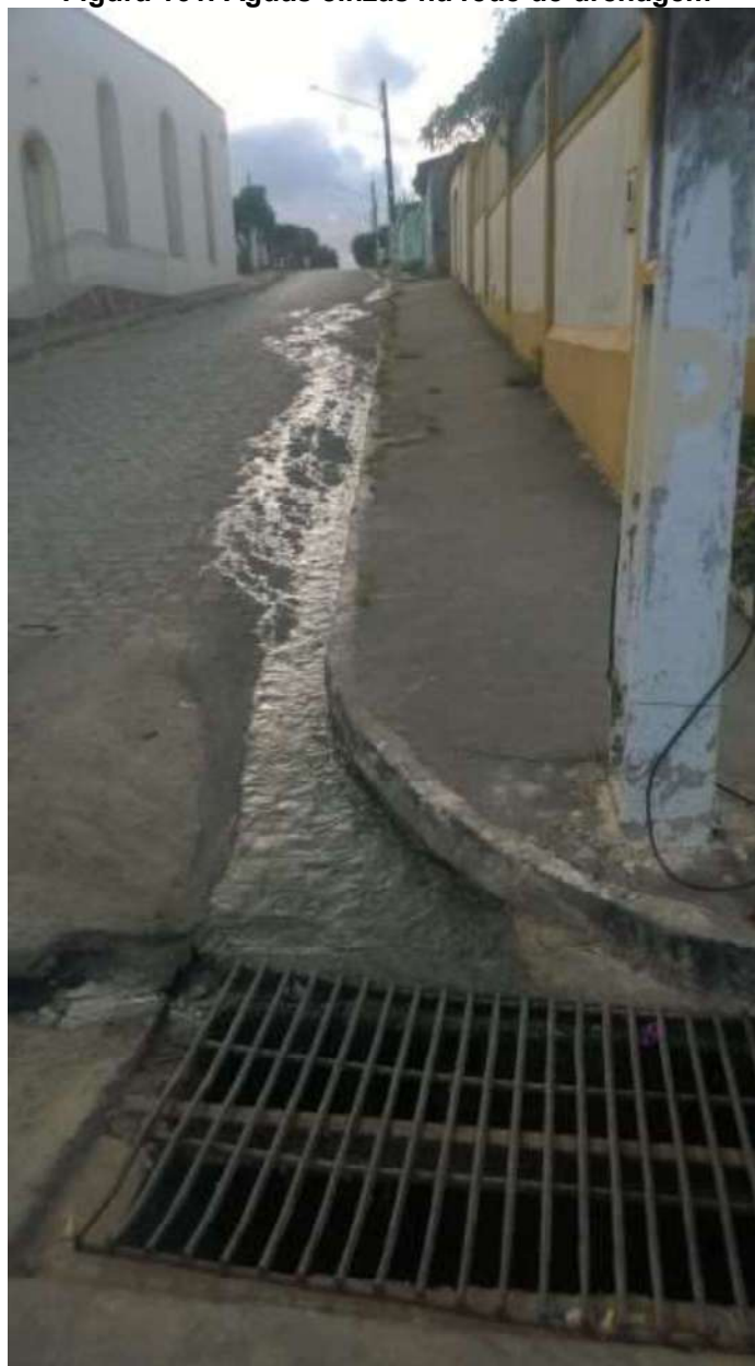
Figura 161. Águas cinzas na rede de drenagem
