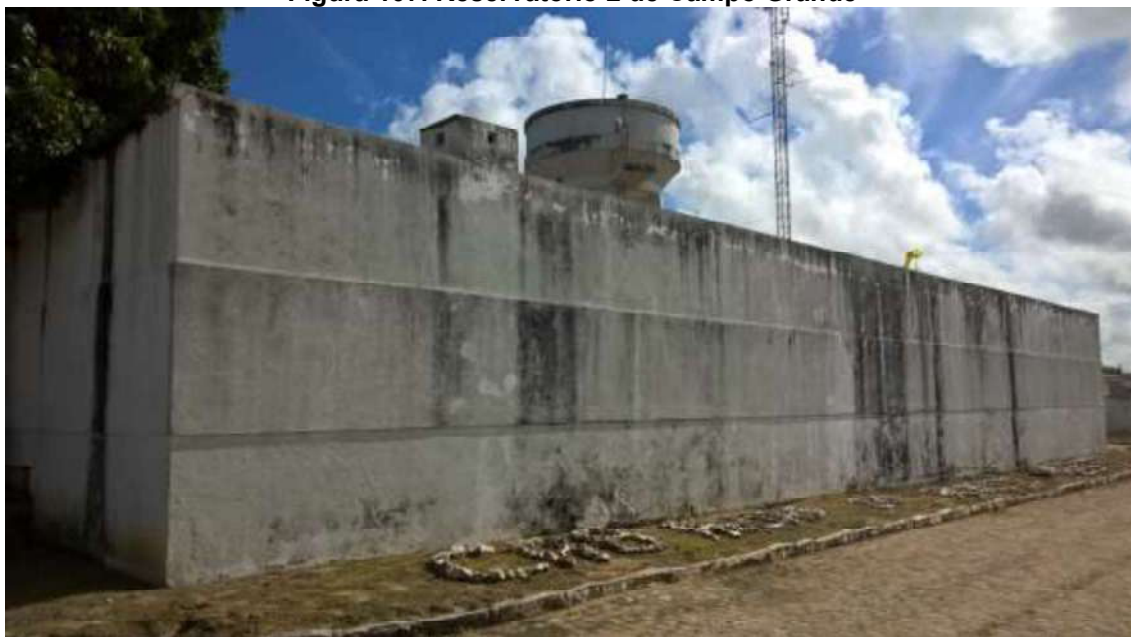
Figura 107. Reservatório 2 de Campo Grande
