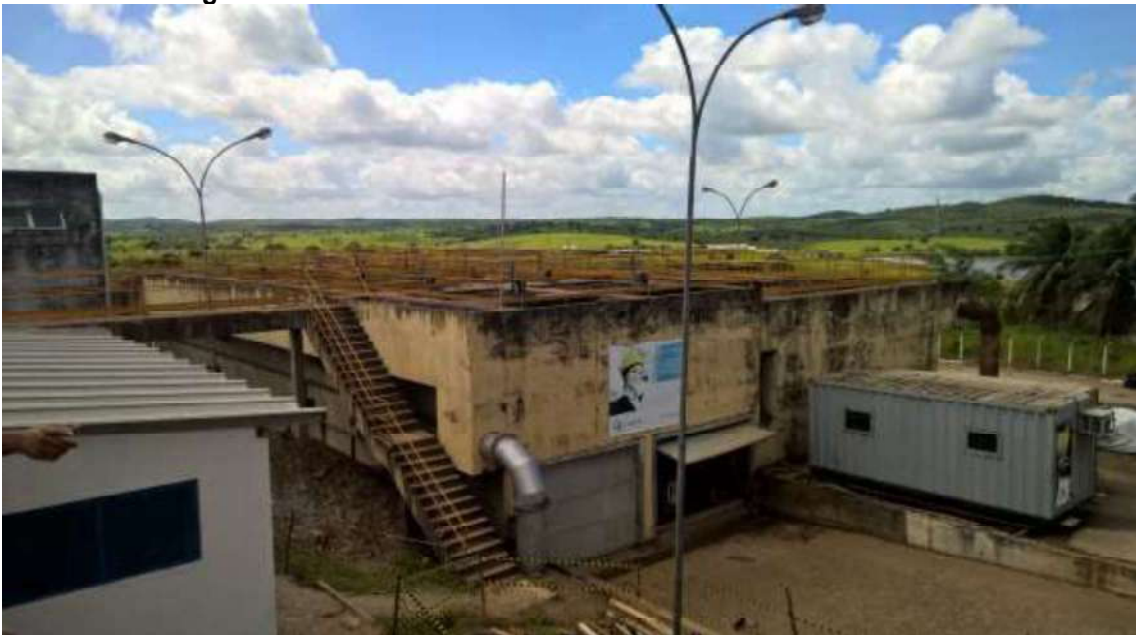
Figura 98. Módulo de Tratamento 02 da ETA do Morro do Gaia
