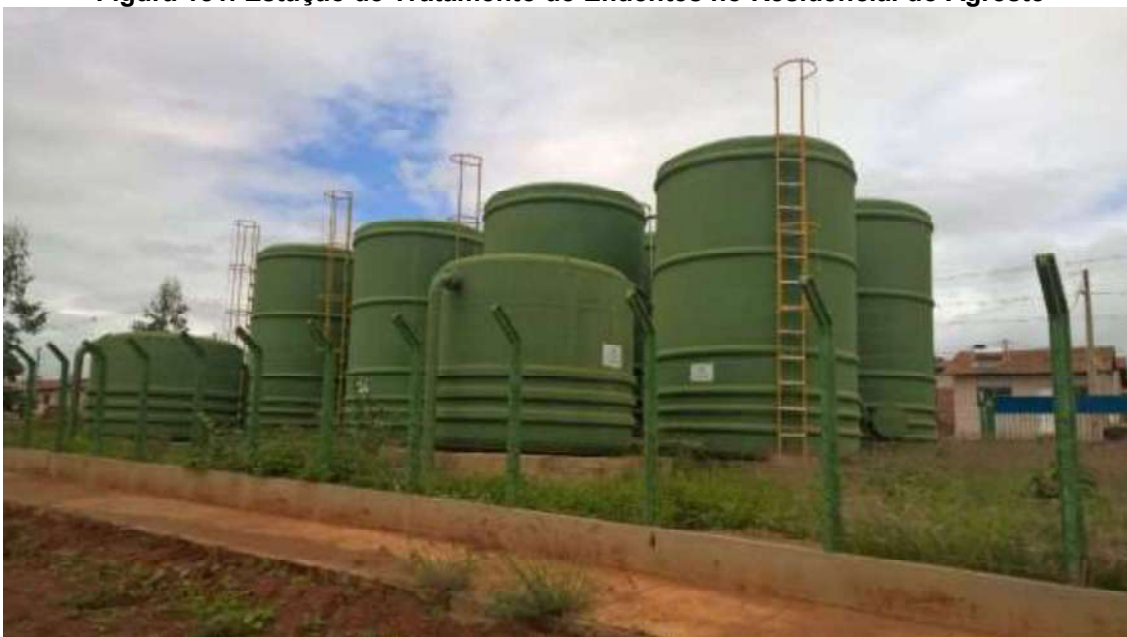
Figura 181. Estação de Tratamento de Efluentes no Residencial do Agreste
