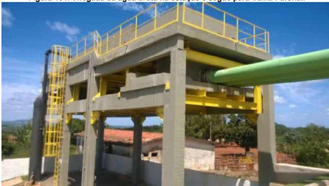
Figura 131. Chegada da água bruta na estação e segue para Calha Parshall
