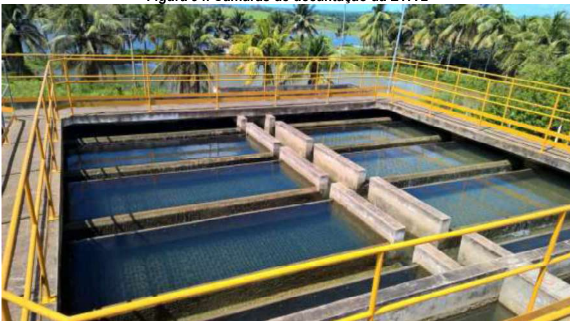
Figura 94. Câmaras de decantação da ETA 2
