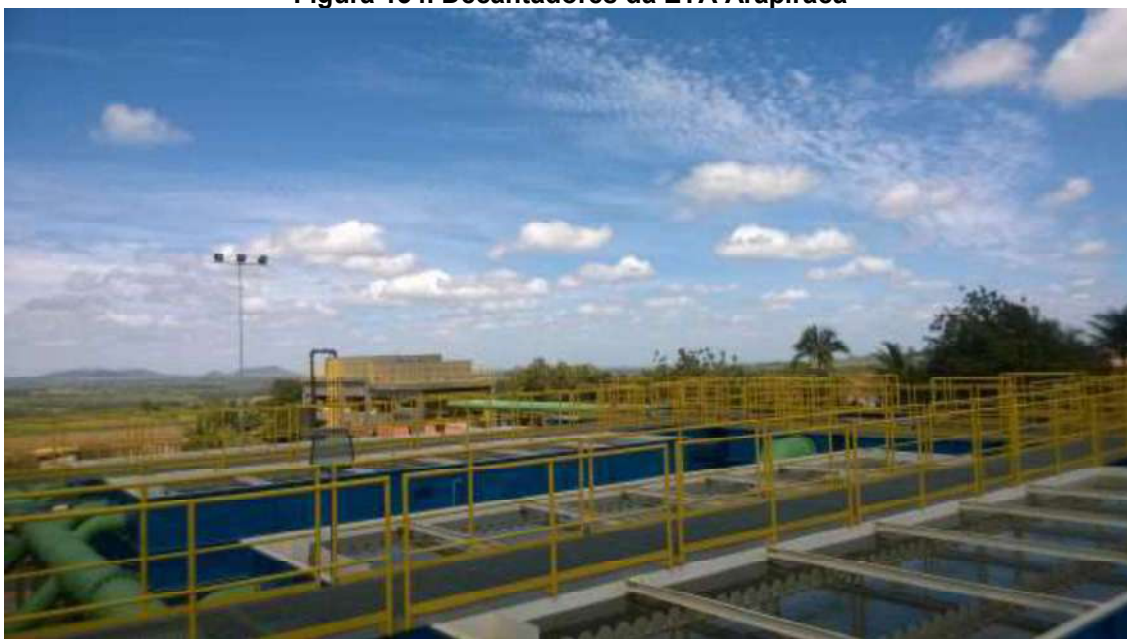
Figura 134. Decantadores da ETA Arapiraca
