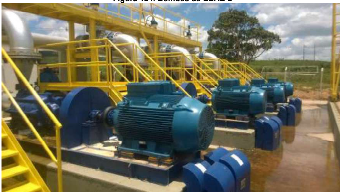
Figura 124. Bombas da EEAB 2
