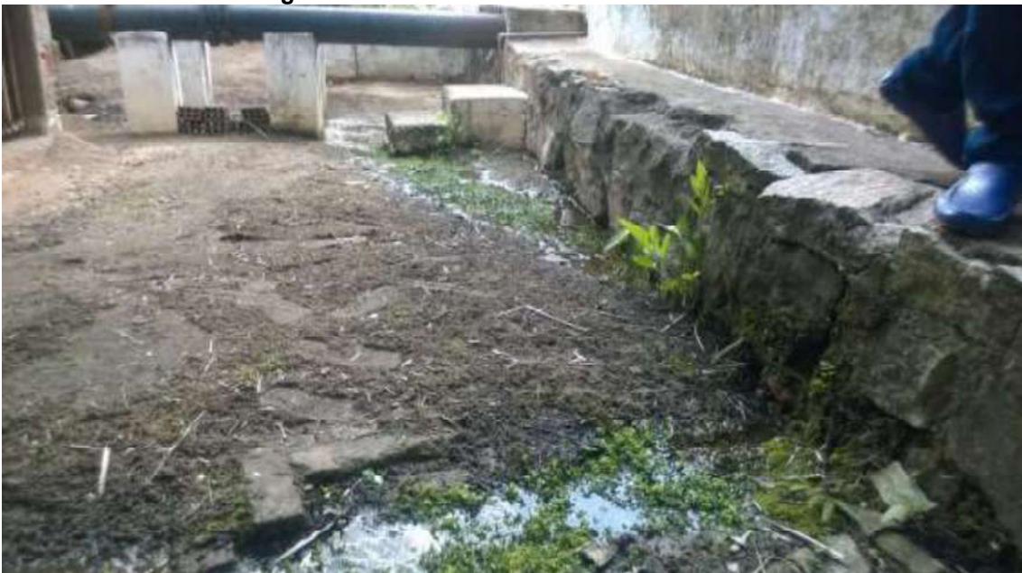
Figura 147. Vazamentos através da estrutura
