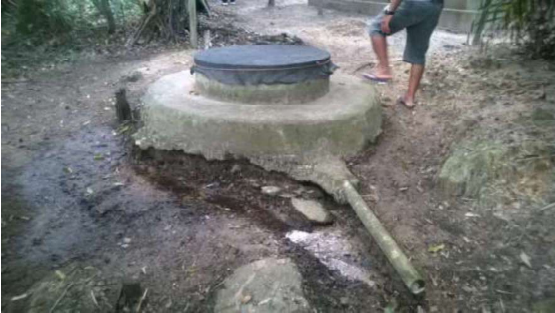
Figura 151. Poço particular na Vila Bananeira – Zona Rural
