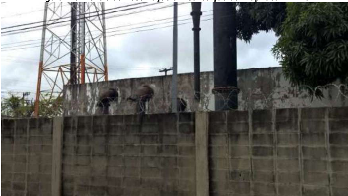
Figura 113. Centro de Reservação e Distribuição de Arapiraca: CRD-02
