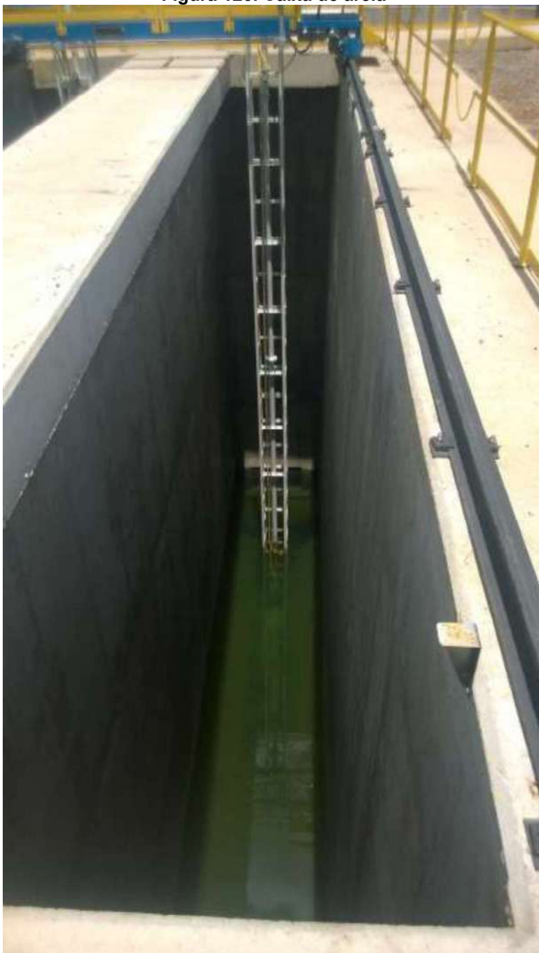
Figura 120. Caixa de areia
