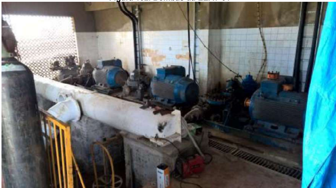
Figura 102. Bombas da EEAT-01
