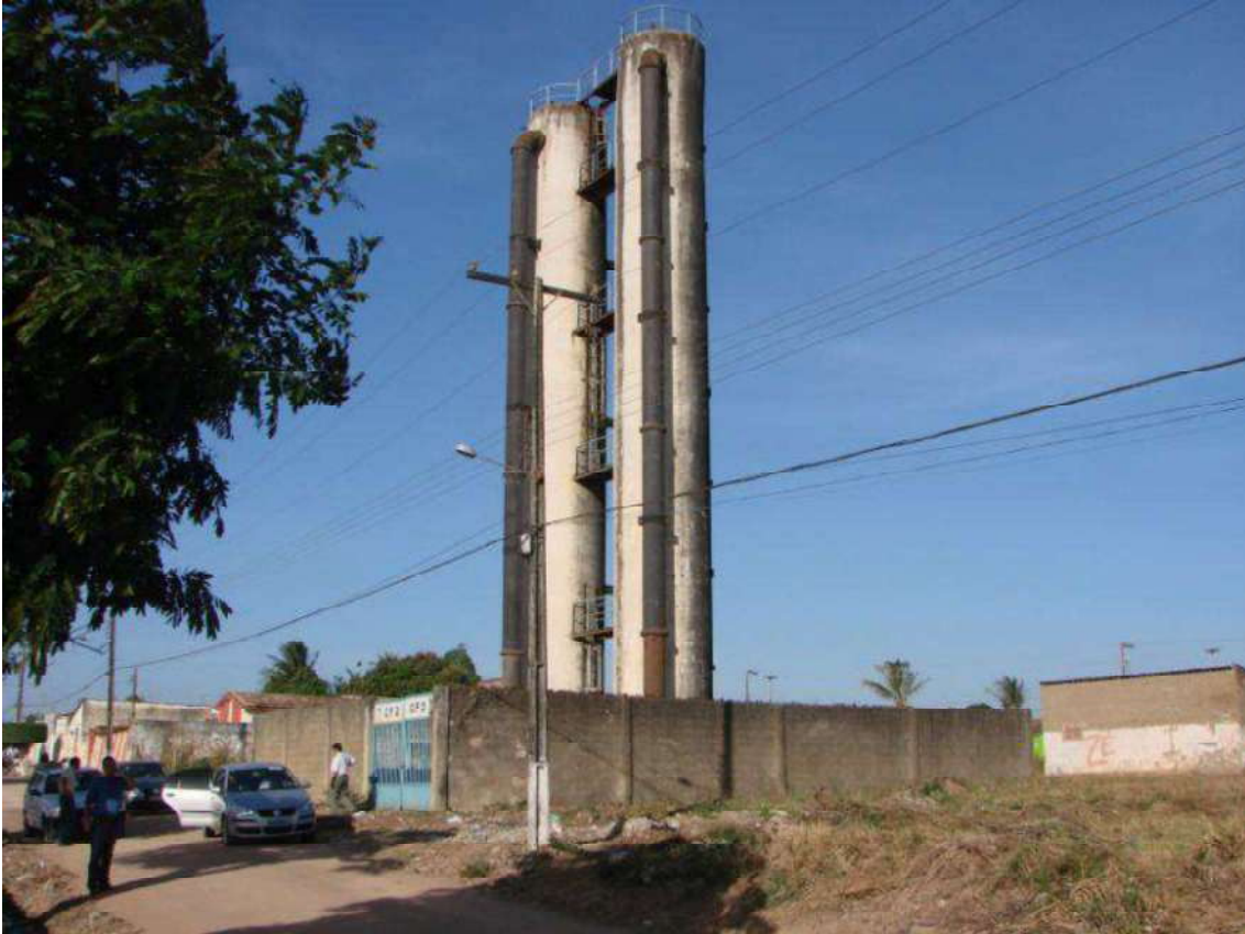
Figura 109. Caixa do Passagem 2 - Arapiraca
