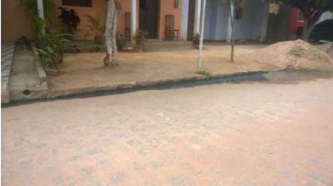
Figura 160. Lançamento de águas cinzas nas sarjetas
