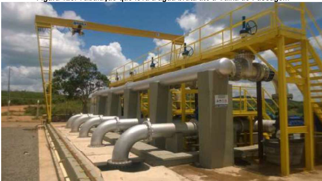
Figura 125. Tubulação que leva a água bruta até a Caixa de Passagem
