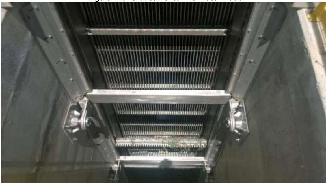
Figura 119. Gradeamento fino mecanizado
