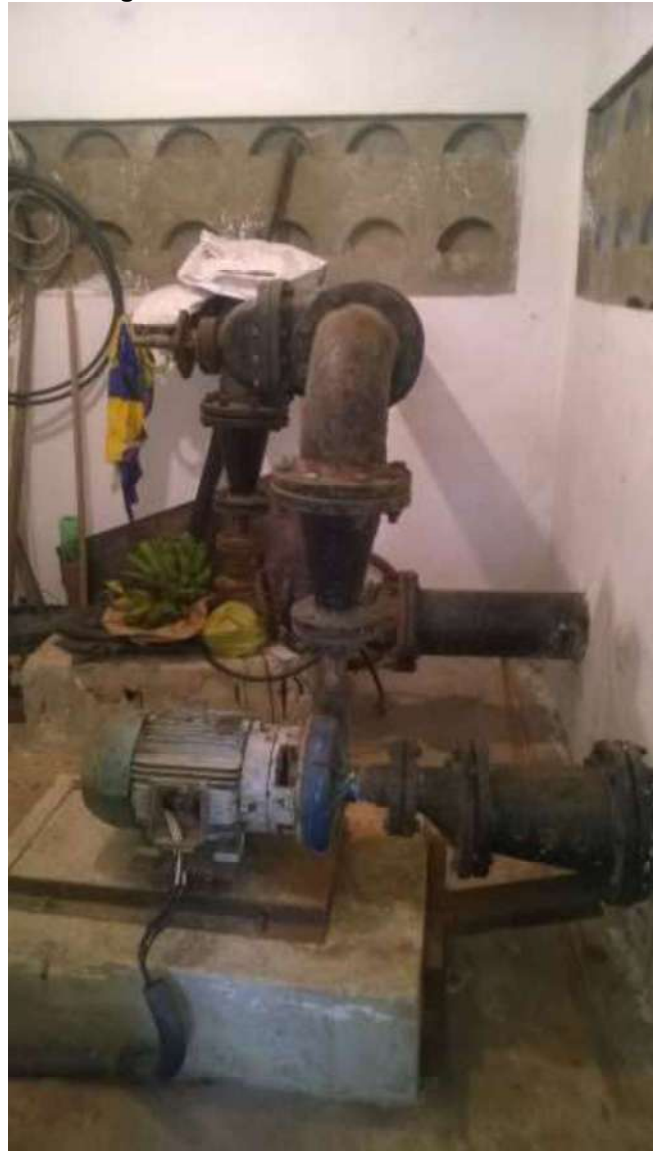
Figura 149. Sistema de bombeamento
