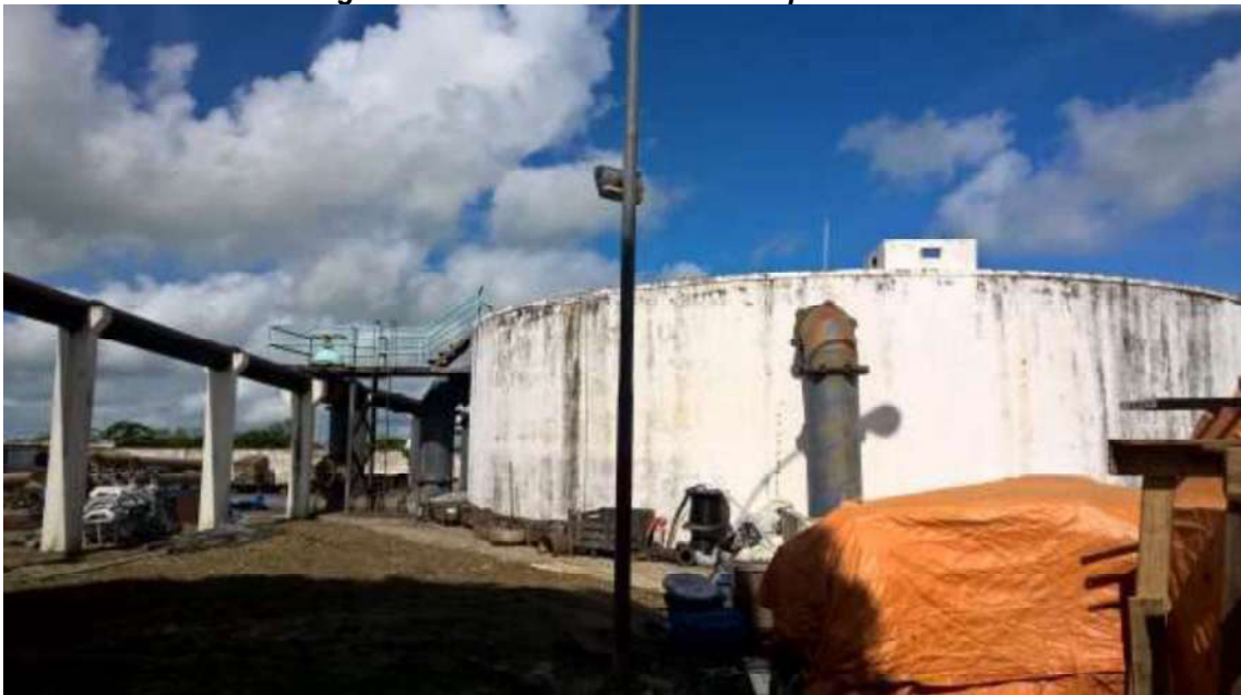
Figura 106. Reservatório 1 de Campo Grande
