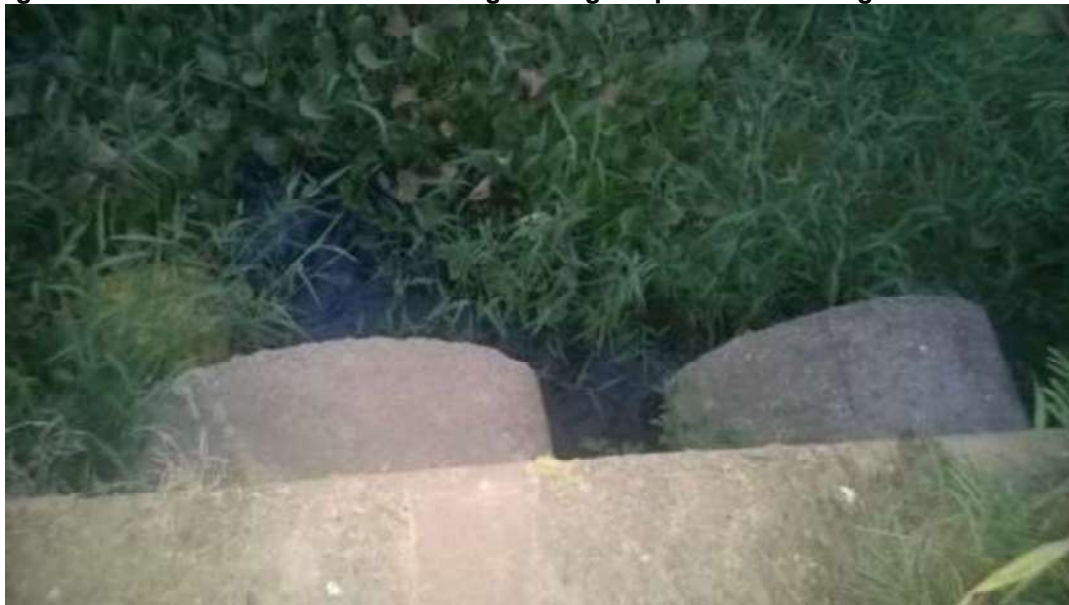
Figura 172. Efluentes formando uma região alagada próxima a Barragem da Bananeira
