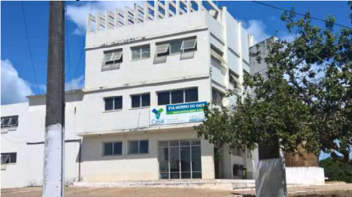
Figura 96. Fachada do prédio da ETA do Morro do Gaia
