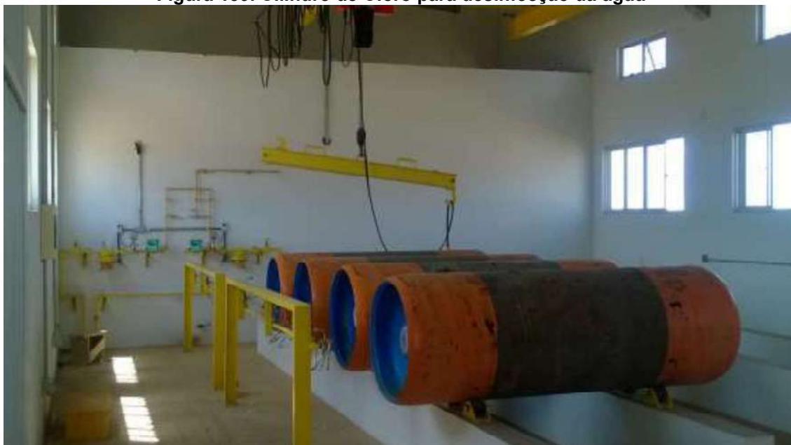
Figura 139. Cilindro de Cloro para desinfecção da água
