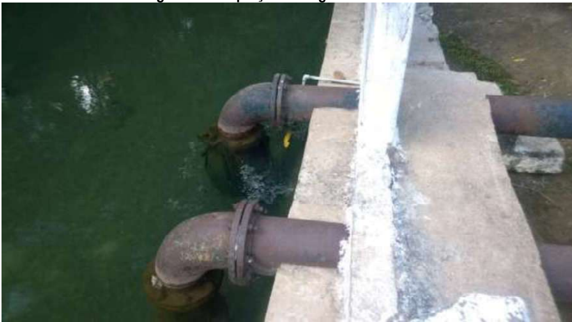
Figura 145. Captação das águas da nascente
