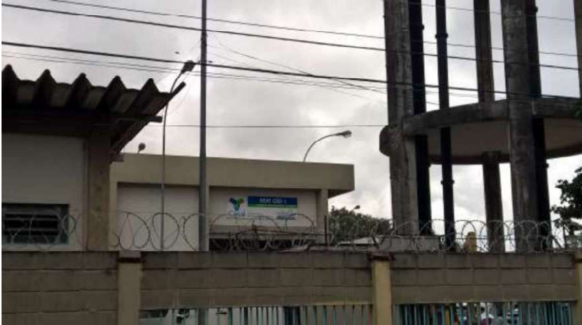
Figura 110. Centro de Reservação e Distribuição de Arapiraca: CRD-01
